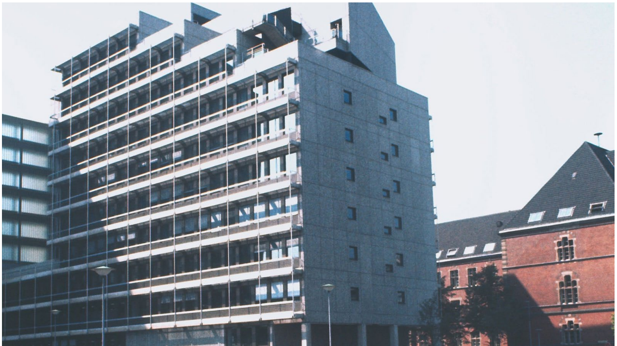
Filmhaus des WDR vor der Sanierung (Quelle: WDR)
