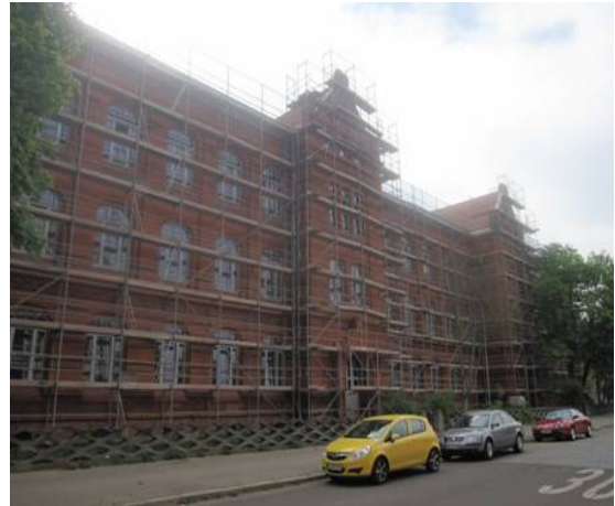
Bsp.: Werner v. Siemens Gymnasium Magdeburg
